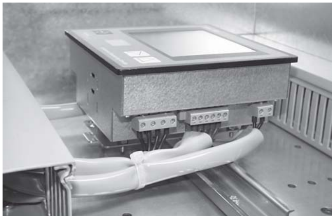
Abb. Leitungszuführung für das UMG505 auf Tragschiene
